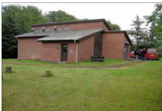
Det nye vandværk placeres ved det nuværende Frenderup Vandværk, som sammen med Stege Vandværk vil blive sat ud af drift, når det nye værk er klar til at tage over. Foto: Vordingborg Forsyning
